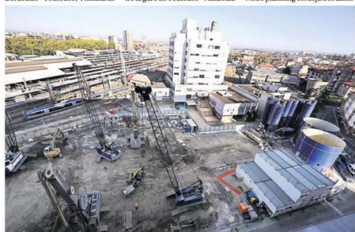
Travaux au sein de l'emprise de la future station Matabiau./Photo DDM, Michel Viala.
