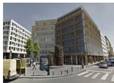
Les locaux d'Airbus dans le quartier européen de Bruxelles. © Google Street View
